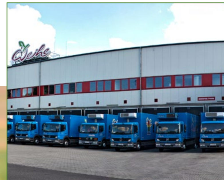
Absolute Frische garantiert – Lagerhalle und Fuhrpark der Weihe GmbH
